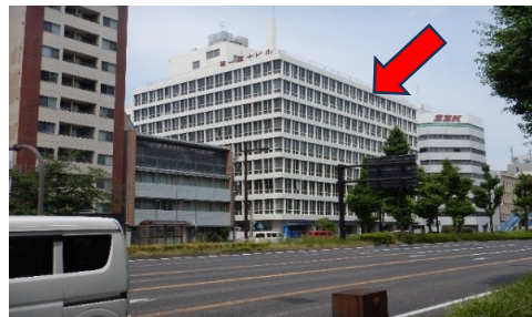
④小川交差点を渡り右方向へ進み1階にローソンが入る白色9階建てビルの5階です。
